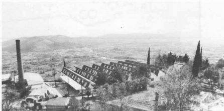
11. Έδessa. Εργουργείο ΣΙΦΕ.ΚΟ Α.Ε. Γενική άποψη από την πόλη.
